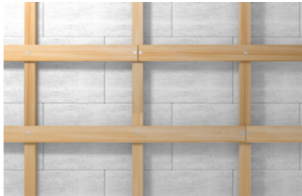
Holzunterkonstruktionen
